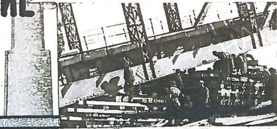
Устройство шпальной клетки под Горбачевской фермой
