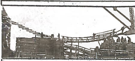
Устройство подвешного мостика между Белевской и Горбачевской фермами. 15.04.42.
